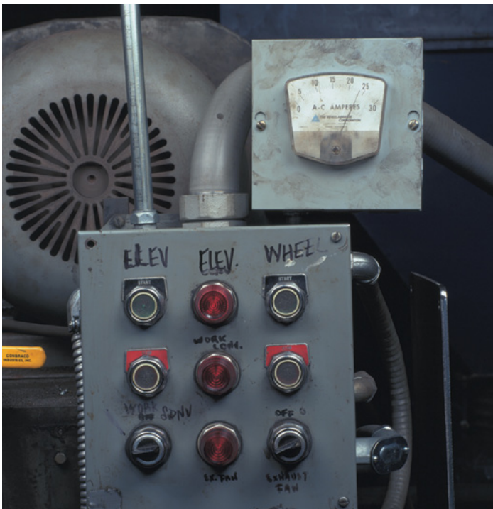
Figura 4. Amperímetro mostrando amperaje de operación
