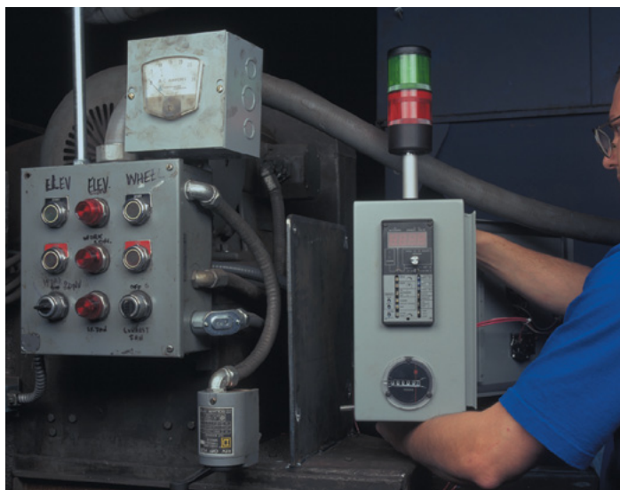
Figura 13. Instalación del panel de control eléctrico con el controlador AC montado a un lado
