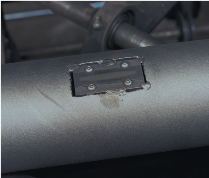
Figura 20. Tira Almen unida a la tubería
